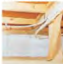
フレキシブルユニット、 CD管フレキによる メーター廻り配管
