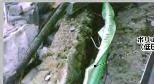
▲地面に露出しても破損のなかったポリエチレン管(低圧導管)(神戸市東灘区)
