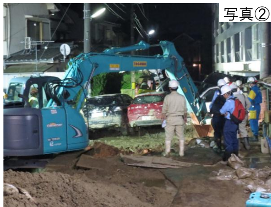
昼夜を徹しての土砂撤去
