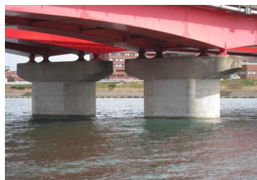
橋脚巻立て (対策後)
