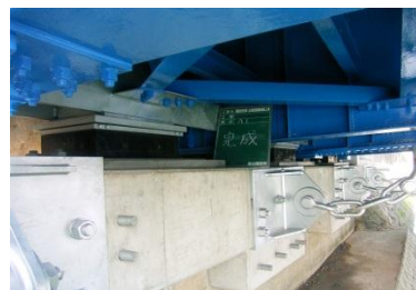
落橋防止装置 (対策後)
