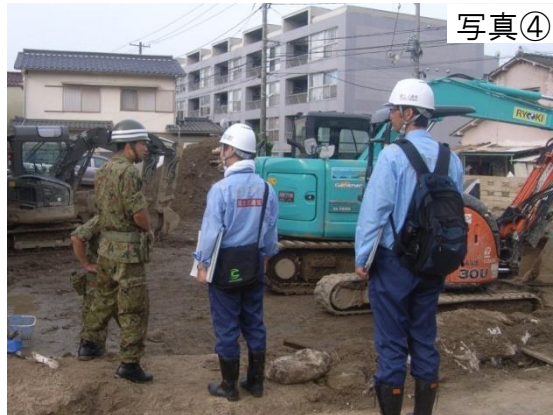
関係機関との調整しながらの土砂撤去
