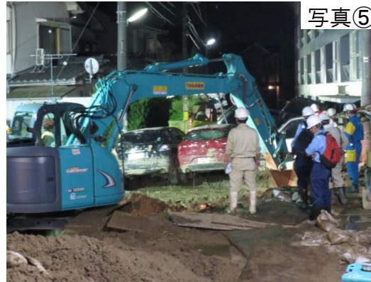
撤去中(夜間作業)
