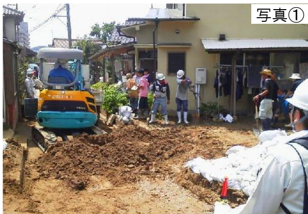
住民と調整しながらの土砂撤去
