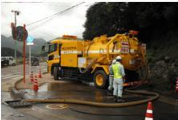
消毒作業に使用する水の給水支援(12/30)
