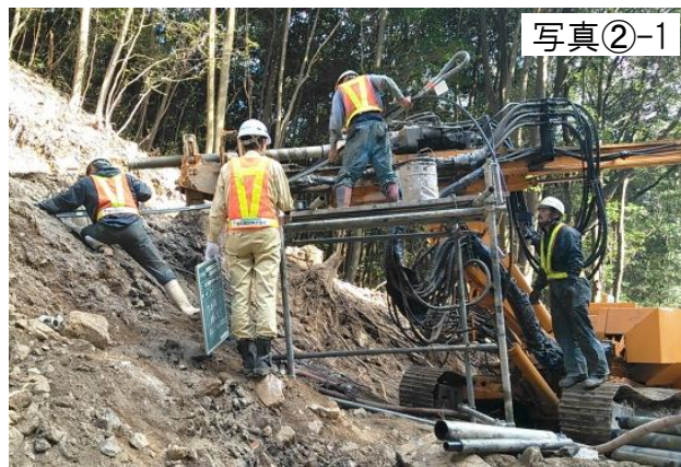
強靱ワイヤーネット工施行状況(削孔)
