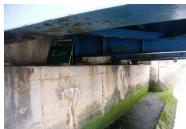
落橋防止装置 (設置前)
