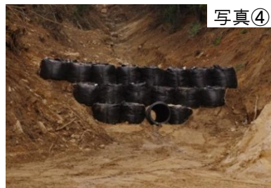
応急対策として 溪流に設置した大型土のう
