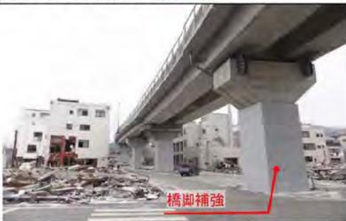
国道45号（観測震度：震度6弱）
