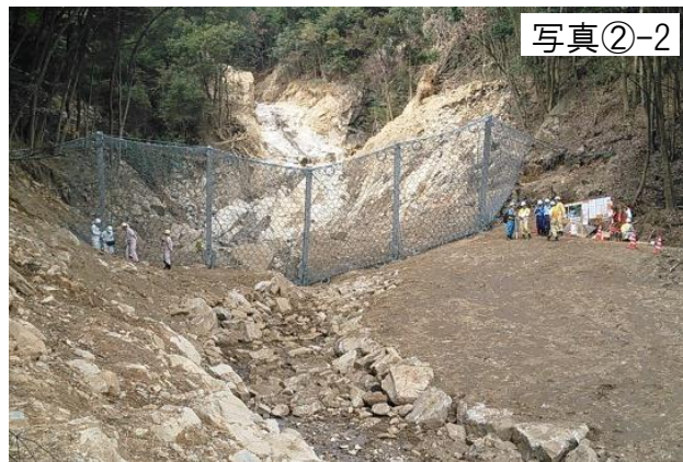
強靱ワイヤーネット工完成
