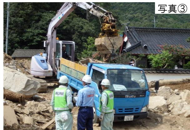
建設会社と調整しながらの土砂撤去
