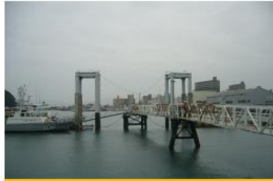
防波堤～棧橋までの橋
