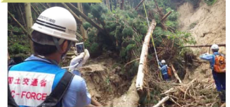
【H26.8 広島土砂災害】 (広島県広島市)
