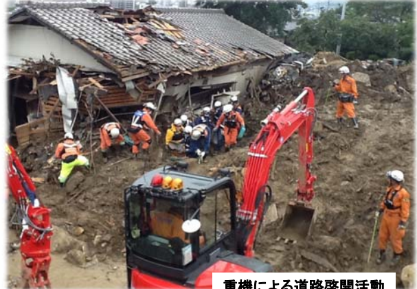
重機による道路啓開活動
