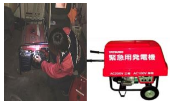
・自家発電機の導入
