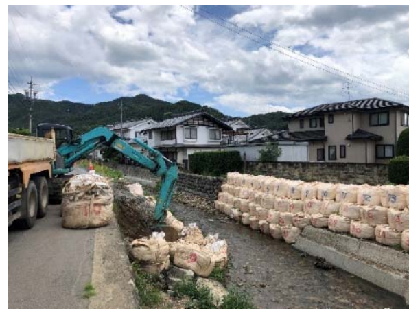
▲被災箇所（佐久市：谷川）
