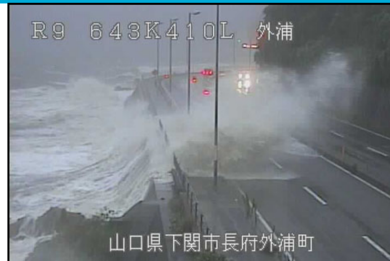
越波による冠水 国道9号 山口県下関市長府外浦町 令和3年9月17日
