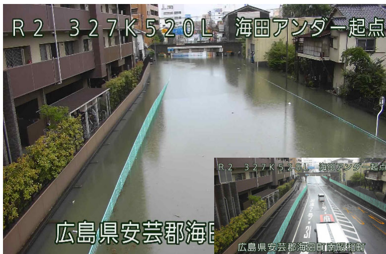
大雨による冠水 国道2号 広島市安芸郡海田町 令和3年7月8日
