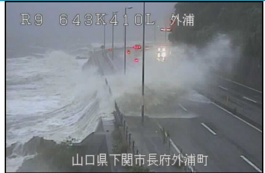
越波による冠水 国道9号 山口県下関市長府外浦町 令和3年9月17日
