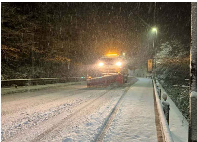
道路除雪作業(国道9号)
