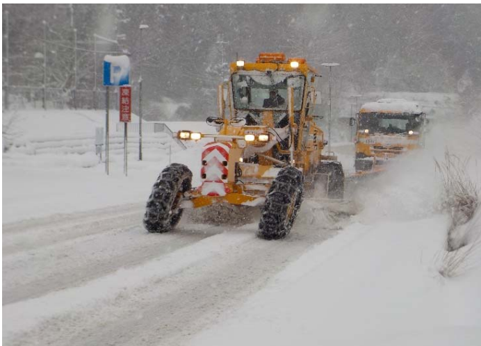
道路除雪作業(国道54号)
