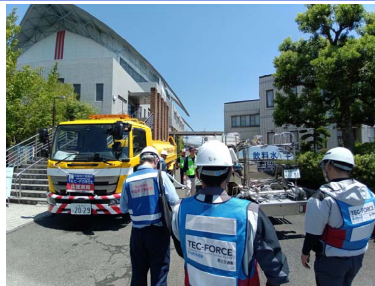
給水車への補充作業 (熊本市上下水道局)
