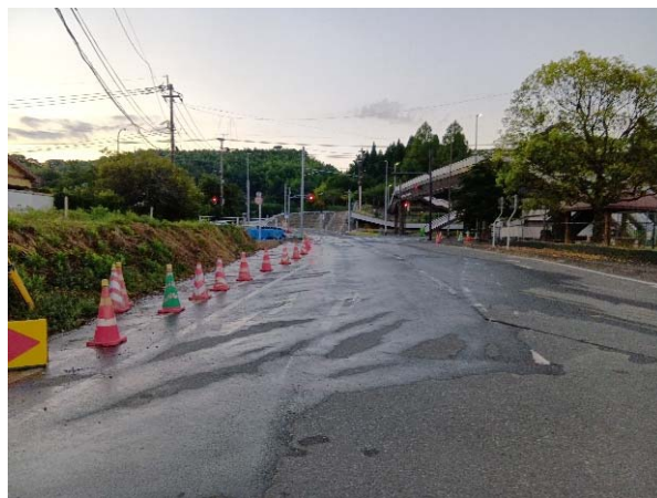
散水作業 (国道3号大野交差点付近)
