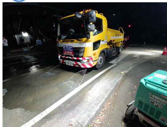
散水作業 (国道3号大野交差点付近)
