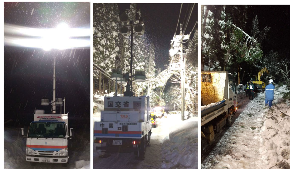
智頭町(上)、佐治町(下)における照明車の現地作業状況
