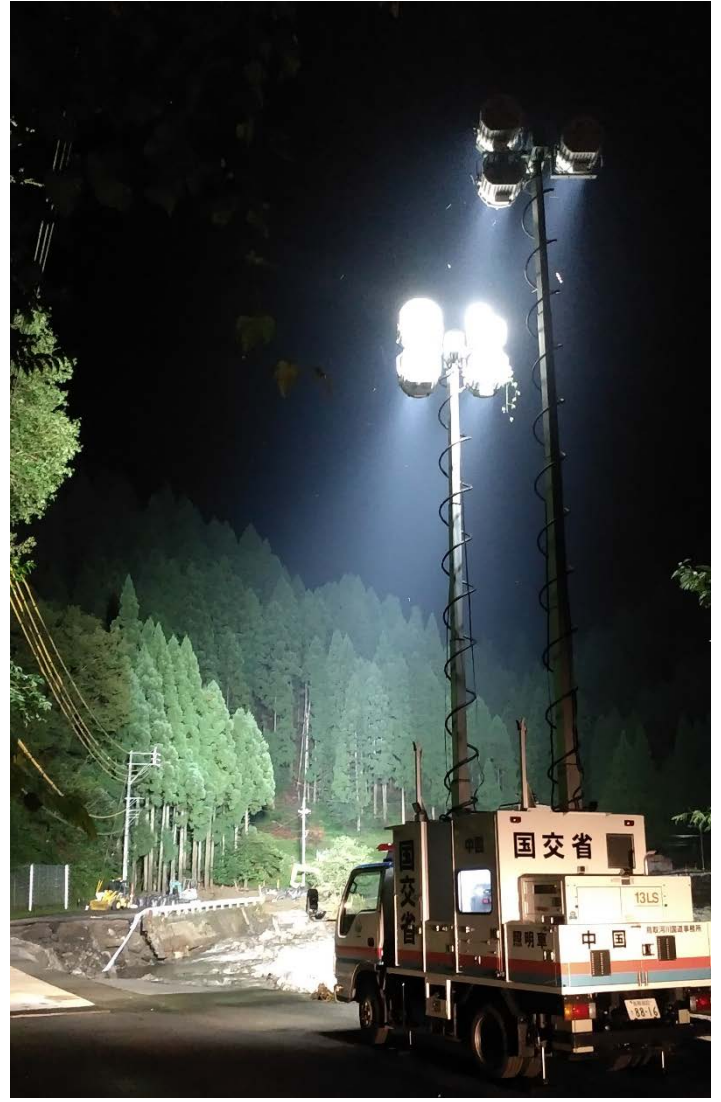
照明車による夜間作業支援 さじ (鳥取市佐治地内)
