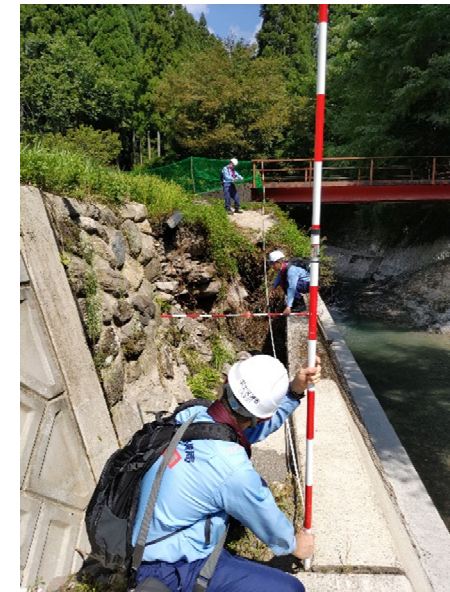
調査状況 (河川班1) さじ おわい (鳥取市佐治町尾際)
