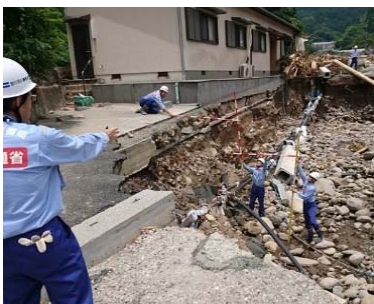
河川被害状況の調査
