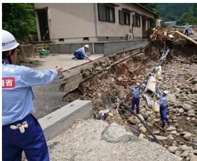
河川被害状況の調査
