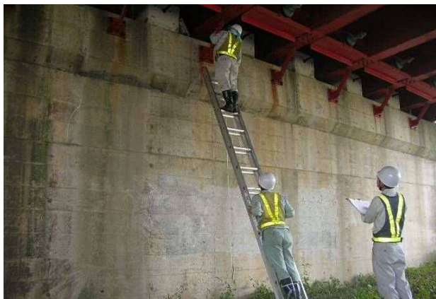
(梯子による定期点検)
