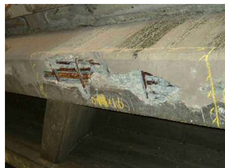
中性化及び経年劣化により、主桁に発生した剥離・鉄筋露出
