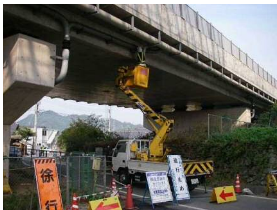
(高所作業車による定期点検)
