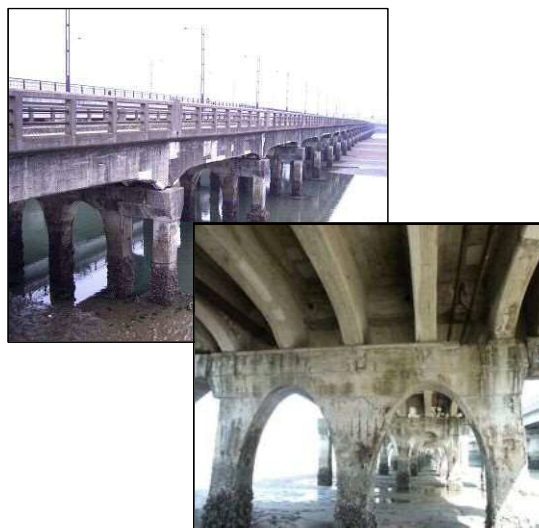
国道190号 厚東川大橋(山口県宇部市藤曲) ・1935年建設 (コンクリート橋) ・塩害による主桁、下部工の損傷が激しいため、 1997年架替 (経年数62年)
