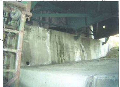
アルカリ骨材反応による ひびわれ
