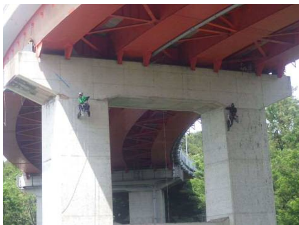
(ロープアクセスによる定期点検)
