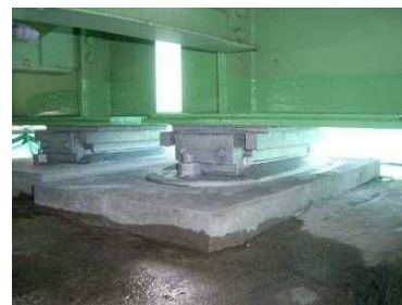
対策後（修繕実施）
