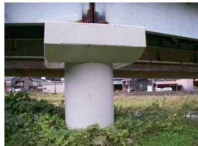
対策後(修繕実施)
