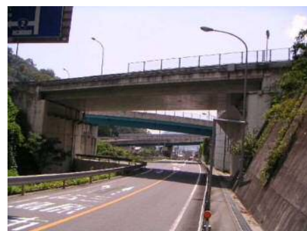
国道2号 恵下谷橋
