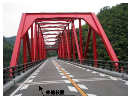
国道9号 東津和野大橋
