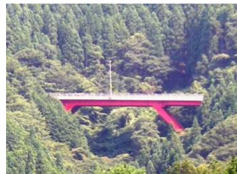
国道53号 杉見橋
