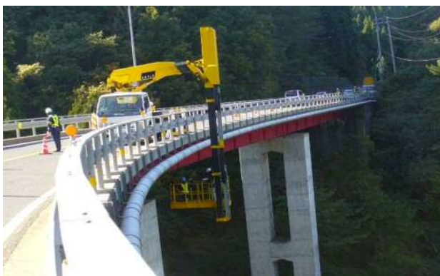
(橋梁点検車による定期点検)
