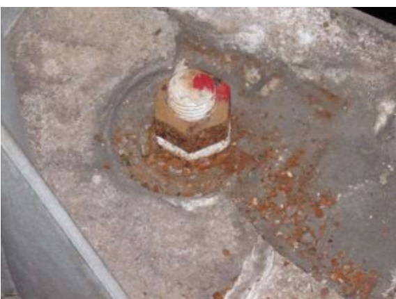
⑥支柱基部のボルトの腐食
