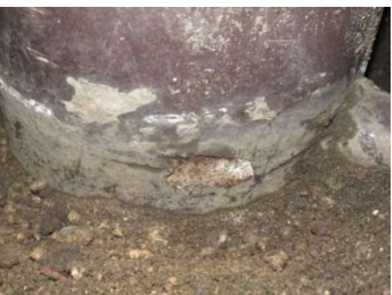
⑤支柱基部の腐食
