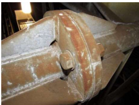
⑥支柱基部のボルトの腐食
