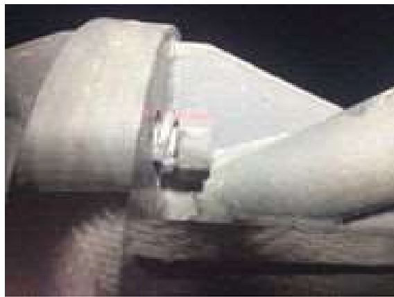
④横梁継ぎ手部の腐食(防食機能の劣化)
