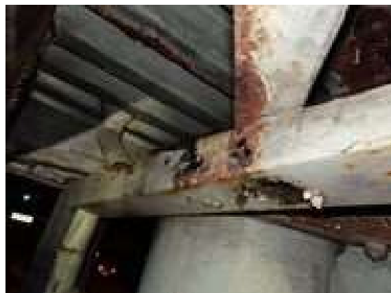
⑥排水樋部の腐食
