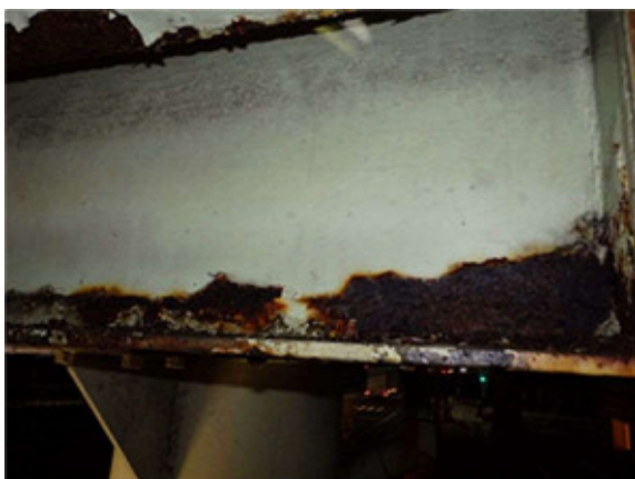
③床版部デッキプレートの腐食
