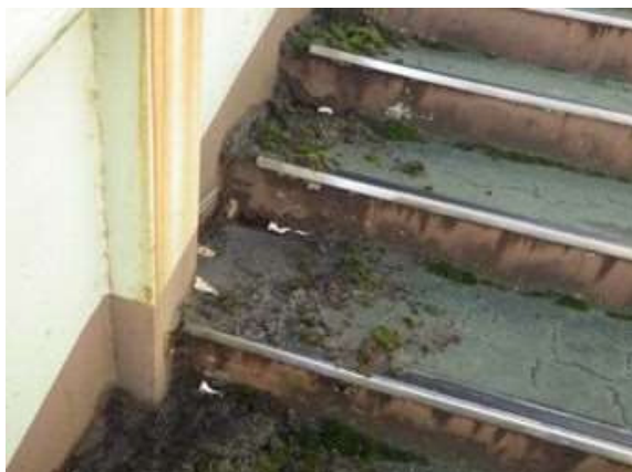
⑤階段蹴上げ部の腐食
