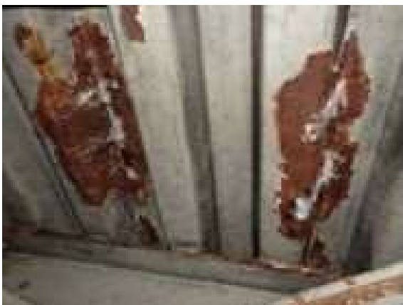
⑤階段蹴上げ部の腐食
