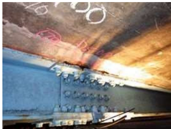
⑥排水樋部の腐食
