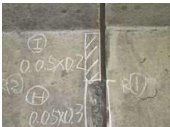
③横梁部のうき、はく離(鉄筋露出)
