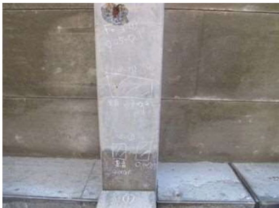
③横梁部のうき、はく離(鉄筋露出)
