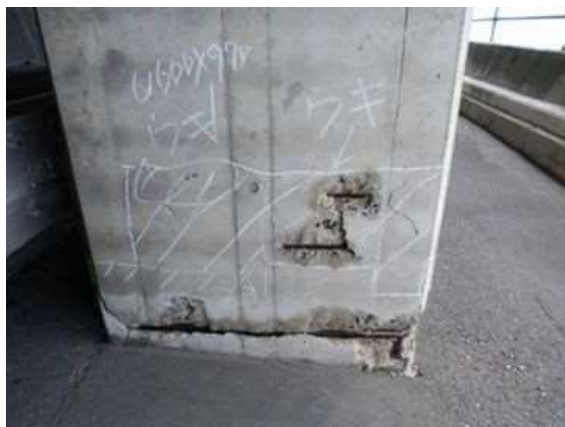
④排水管取付金具の腐食
