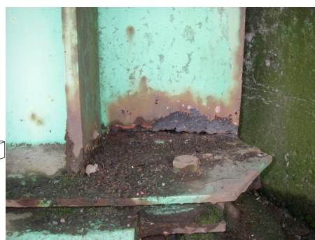
伸縮装置部からの漏水の影響による主桁端部の腐食
