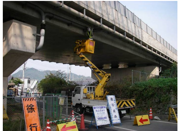
(高所作業車による定期点検)
