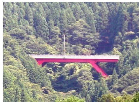
国道53号 杉見橋
