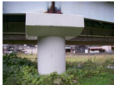
対策後(修繕実施)
