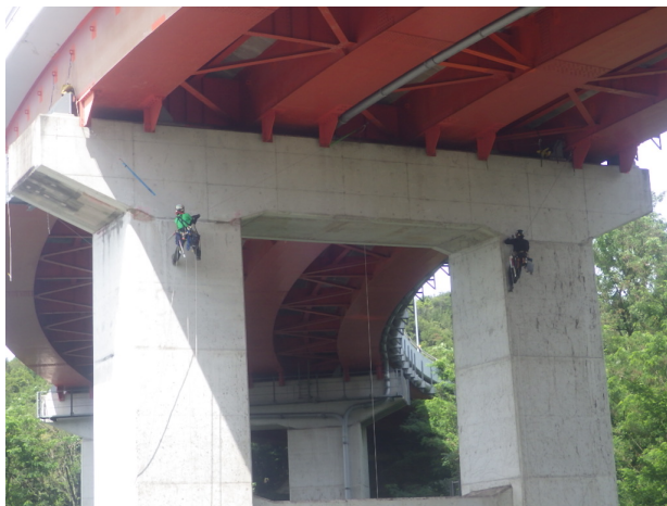
(ロープアクセスによる定期点検)
