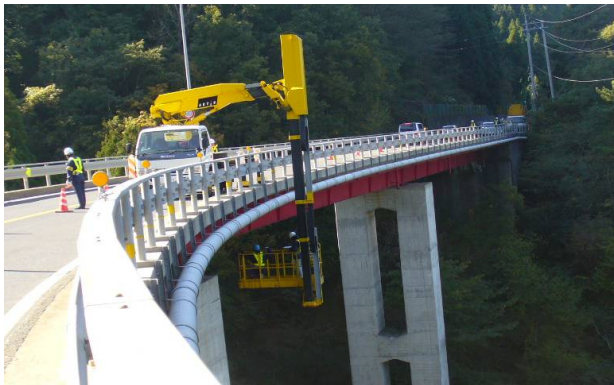
(橋梁点検車による定期点検)
