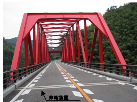
国道9号 東津和野大橋
