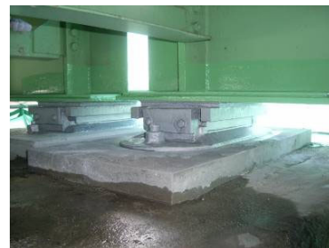
対策後(修繕実施)
