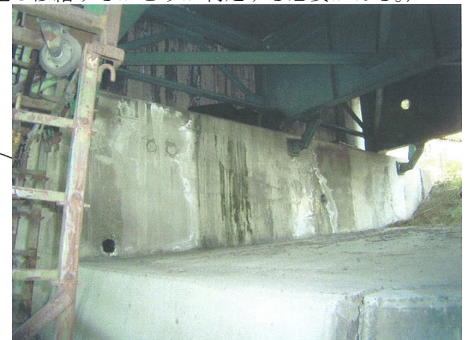
アルカリ骨材反応によるひびわれ
