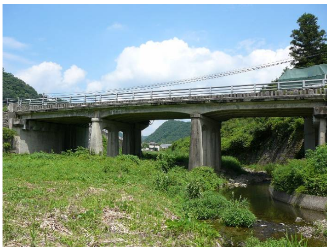
国道53号 白石橋(岡山市建部町) (1936年完成 供用年数85年)
