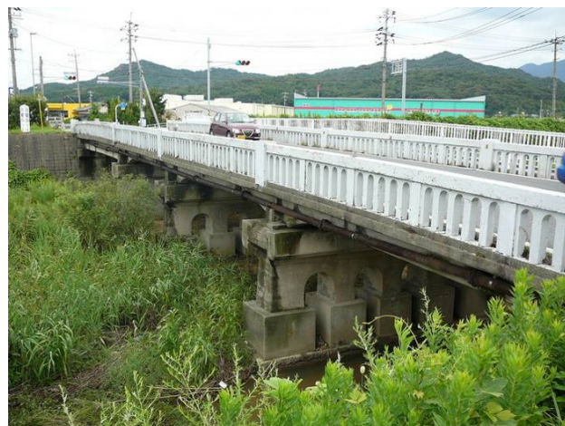
国道191号 葉中橋(山口県下関市豊浦町) (1932年完成 供用年数89年)
