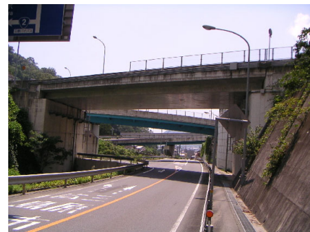
国道2号 恵下谷橋
