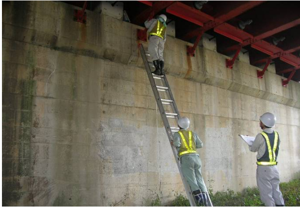
(梯子による定期点検)
