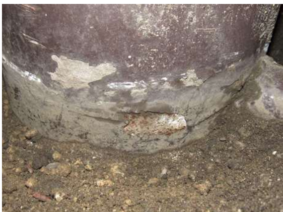
⑤支柱基部の腐食
