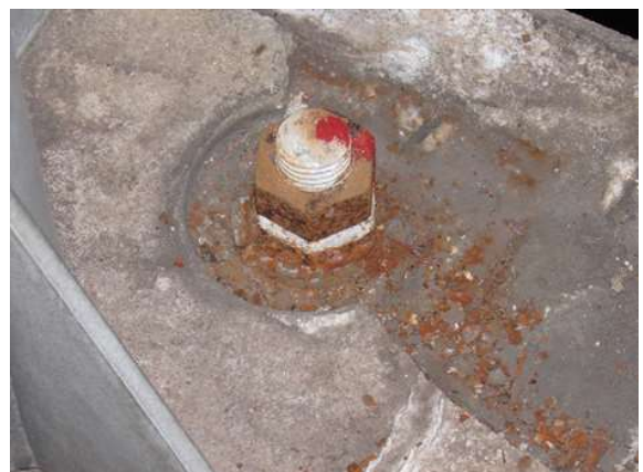
⑥支柱基部のボルトの腐食
