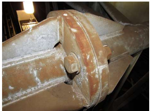
⑥支柱基部のボルトの腐食
