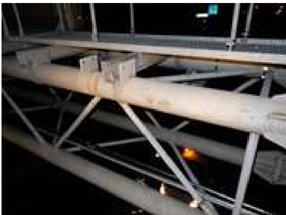
⑤支柱基部の腐食
