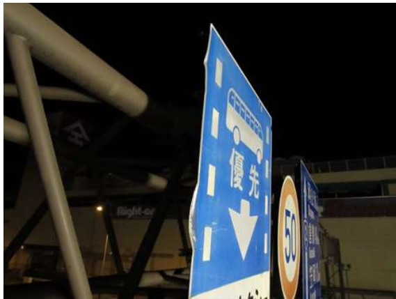
③横梁の腐食(防食機能の劣化)
