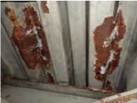
⑤階段蹴上げ部の腐食
