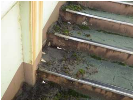
⑤階段蹴上げ部の腐食
