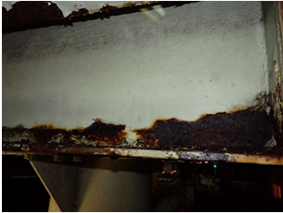
③床版部デッキプレートの腐食
