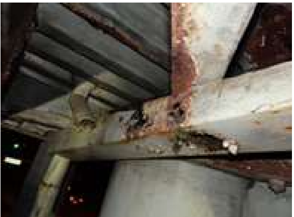
⑥排水樋部の腐食
