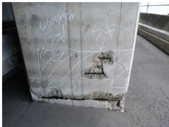
④排水管取付金具の腐食
