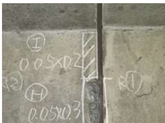
③横梁部のうき、はく離(鉄筋露出)
