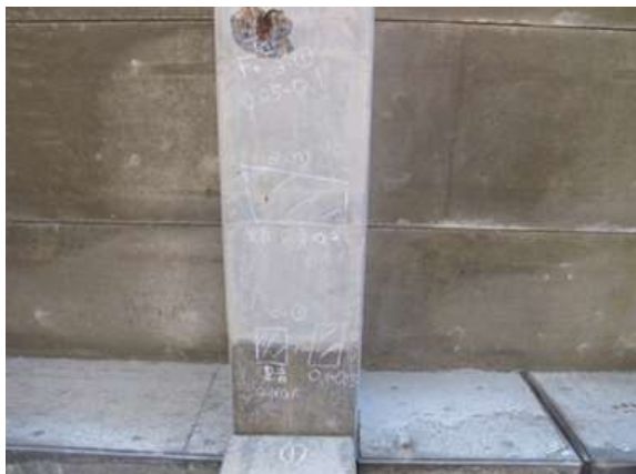
③横梁部のうき、はく離(鉄筋露出)
