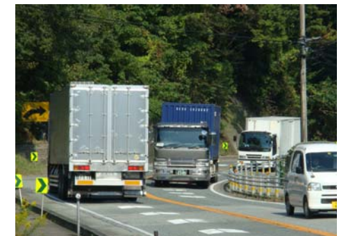
線形不良箇所(浜田市三隅町向野田)
