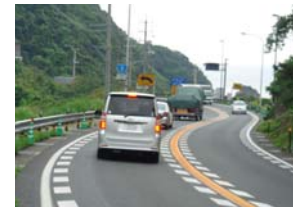
線形が悪い箇所 (国道9号)
