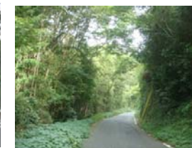
幅員が狭い箇所 (川平停車場線)
