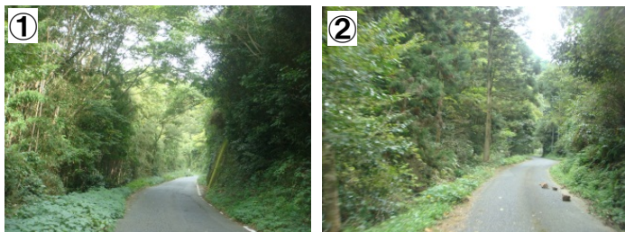
幅員が狭く、緊急車両や貨物車の通行が困難
