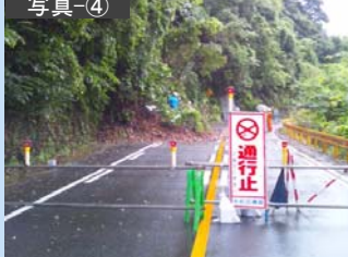
▲長門市俵山(H25.9 被災状況)
