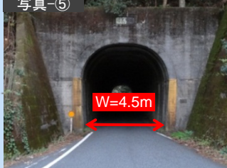
▲幅員狭小(豊田湖沿いの葛尾隧道)
