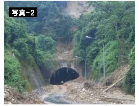
▲ 国道315号金山谷トンネル (H25. 7. 28)
