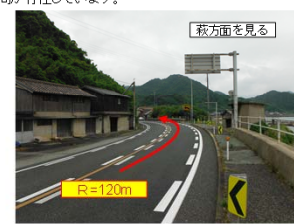
▲平面線形不良箇所
