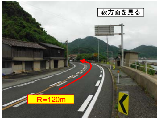
▲平面線形不良箇所
