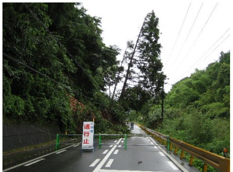
▲長門市俵山 【被災状況】
