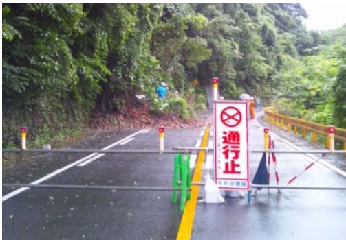
▲長門市俵山 【H25.7 被災状況】
