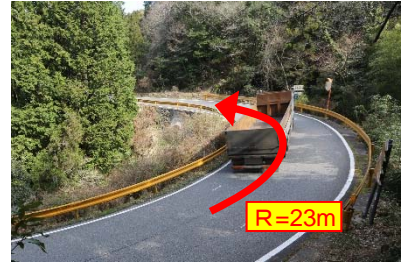
▲平面線形不良箇所
