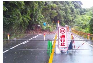
▲通行止め状況
