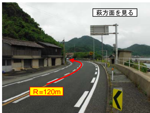
▲平面線形不良箇所
