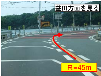
▲平面線形不良箇所
