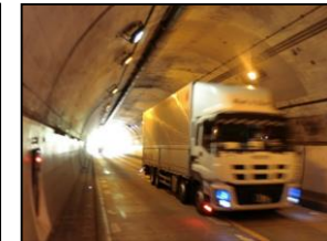
写真5 幅員狭小トンネル
