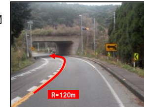
写真4 線形不良箇所
