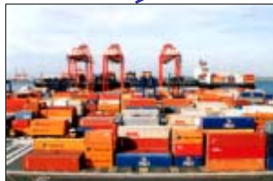
出島国際海上コンテナターミナル
