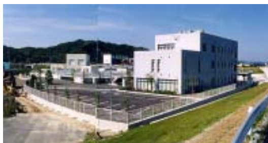
高屋川河川浄化施設
