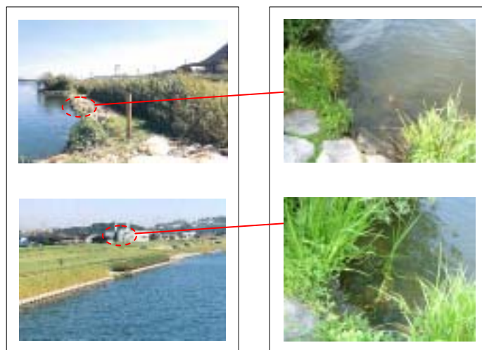
植生浄化護岸の敷設
