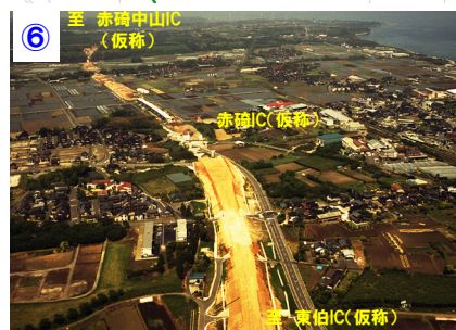
⑥赤碕IC（仮称）付近[米子方面を望む]
