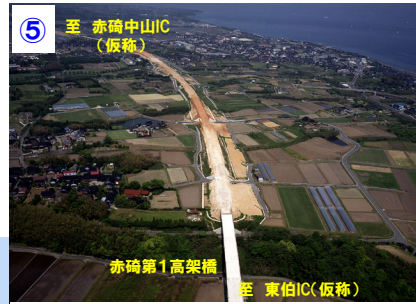
⑤赤碕第1高架橋付近[米子方面を望む]
