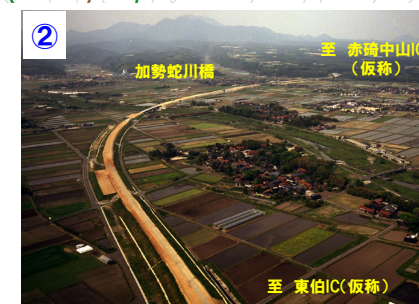
②加瀬蛇川橋付近[米子方面を望む]
