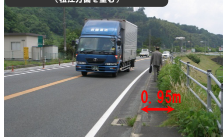
④歩道幅員1.5m以下 (松江方面を望む)
