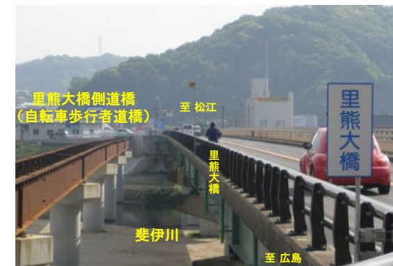
④里熊大橋側道橋(自転車歩行者道橋)の状況 松江方面を望む
