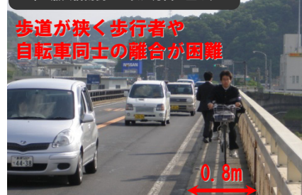
⑤-2歩道幅員1.5m以下 (里熊大橋南側から松江方面を望む)
