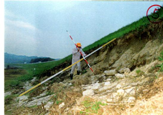
水位計測監視システムを設置し、堤防強化工法の効果検証のためのモニタリングを実施。
