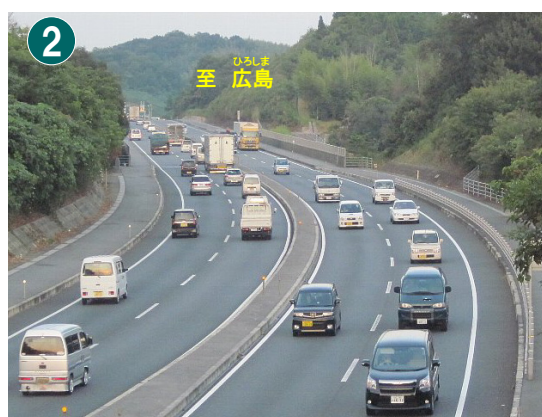
【バイパス区間において広島方面を望む】
