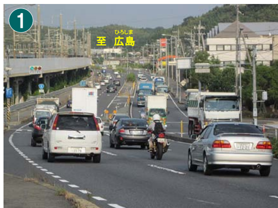
【現道拡幅区間において広島方面を望む】
