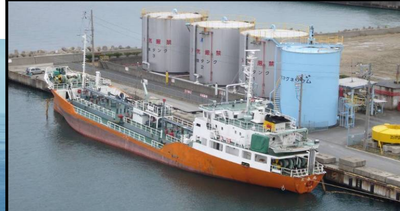
重油取扱状況
