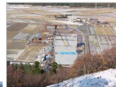
【写真④】鳥取西道路 (野坂川橋下部工施行状況)
