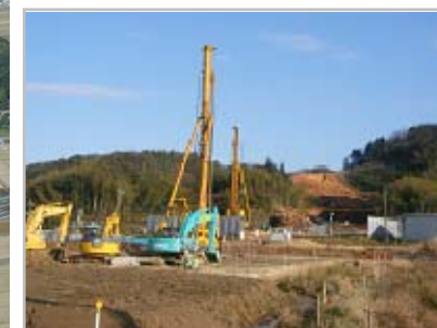
【写真⑤】鳥取西道路 (吉岡温泉IC付近地盤改良施行状況)
