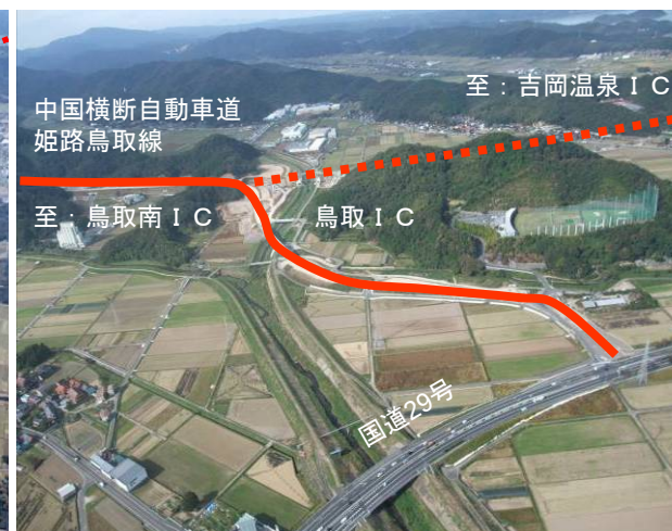
【写真①】鳥取西道路 (国道29号から鳥取IC方面を望む)
