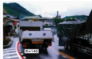
【写真①】平面線形不良箇所 (R=140)
