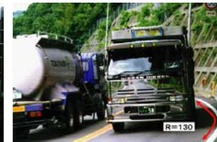
【写真②】平面線形不良箇所 (R=130)
