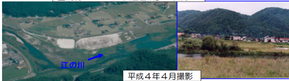
整備前の江の川「長屋箇所」の状況
