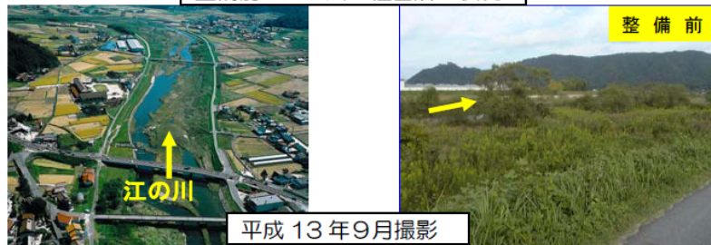
整備前の江の川の桂箇所の状況
