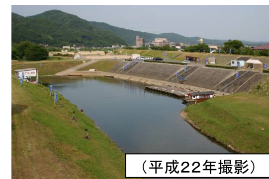
完成後の状況
