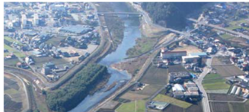
現在の「江の川（甲立箇所）」の状況
