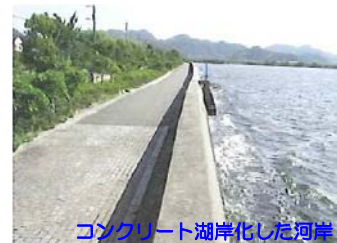
コンクリート湖岸化した河岸
