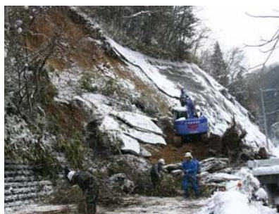
平成17年1月法面崩壊 (国道183号庄原市西城町) 【全面通行止め106時間、片側交互通行350日】
