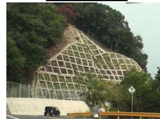
防災対策状況
