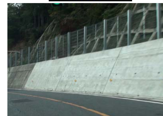
防災対策状況
