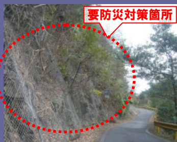
写真② 国道491号砂利ヶ峠 (異常気象時通行規制区間)
