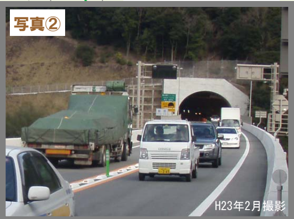
＜飯井第2トンネル付近 萩市方面を望む＞
