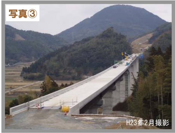
＜吉広高架橋工事 明石ICから三見IC（仮称）方面を望む＞
